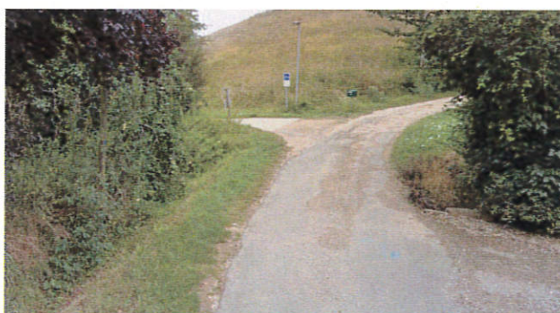
Débouché de la piste en site propre sur le chemin de desserte
