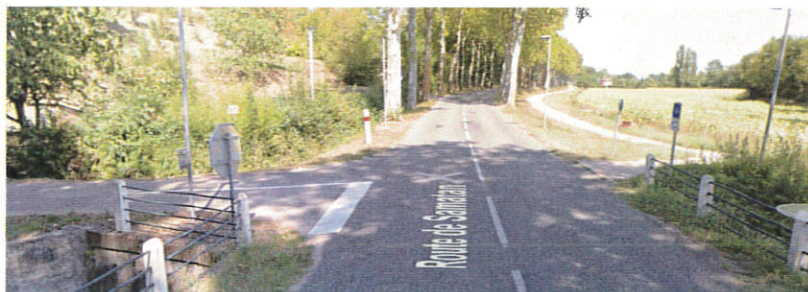
Débouché du chemin de desserte sur la RD 39
